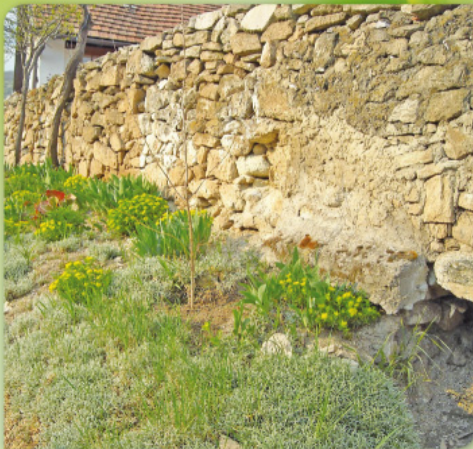
Szárazon rakott kőfal
