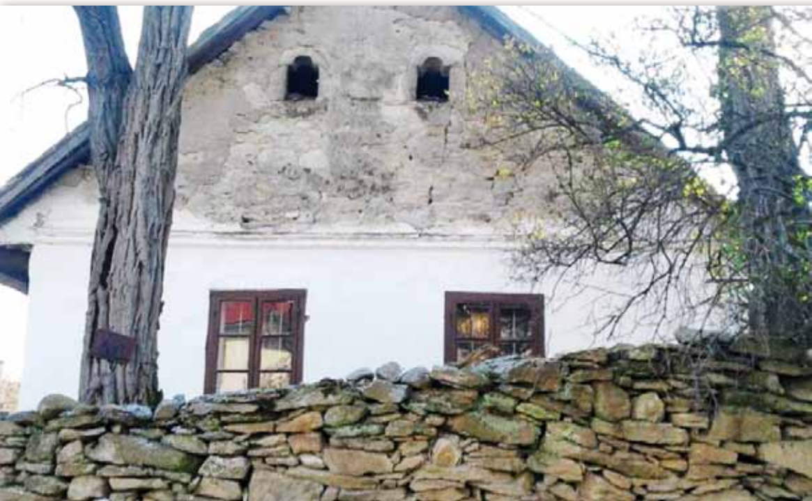
34. A kisgyőri népi építészet értékeit őrző lakóház a templom közelében (Fotó: Szunyogh Szilvia)
